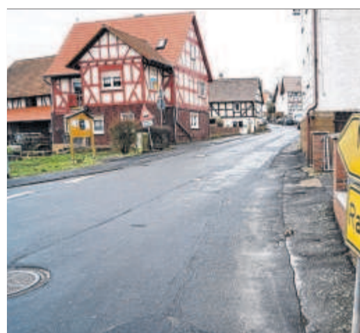
Die Nordecker Ortsdurchfahrt soll in diesem Jahr saniert werden. Das allein kostet die Stadt über 1,2 Millionen Euro. (Foto: pad)
